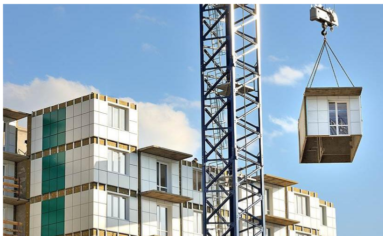
Рисунок 6 Монтаж современного железобетонного модульного-блочного элемента, Россия [1]
